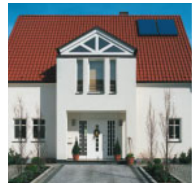
Einfamilienhaus mit einer Schüco Kompakt Anlage zur Warmwasserbereitung
