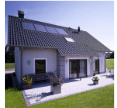
Einfamilienhaus mit einer Schüco Premium Anlage zur zusätzlichen Heizungsunterstützung
