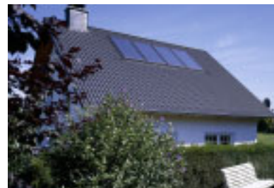
Einfamilienhaus mit thermischer Solaranlage zur zusätzlichen Heizungsunterstützung
