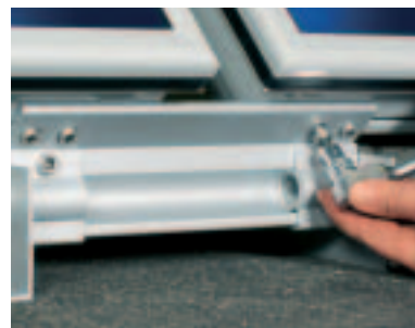
Detail der Flachdachmontage: Nur eine Schraubengröße für alle Montageschritte
